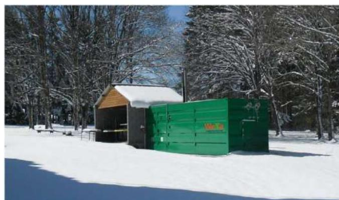
La **WEYA BOX**, **chaudière en container**, permettra de chauffer les 1 600 m<sup>2</sup> de locaux (salles de cours, bureaux, internat, cuisine, réfectoire et logements), et assurera la production d'eau chaude sanitaire.
