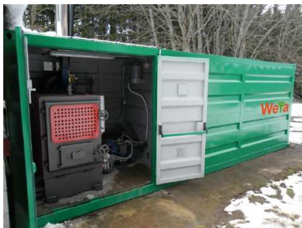
Le container a été placé sur une dalle béton existante puis la chaufferie a été raccordée à la chaufferie existante par un réseau hydraulique enterré de 15 ml.
