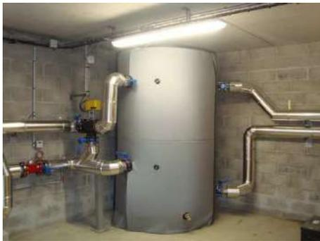
Enfin, Weya a installé un ballon tampon de stockage de l'eau chaude en sortie des chaudières afin de lisser la charge et de profiter de l'inertie des chaudières. Mais également un système de comptage de l'énergie produite et un système de régulation de la production de chaleur.
