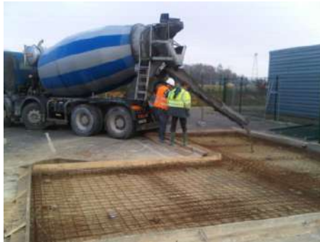
Création de la dalle béton
