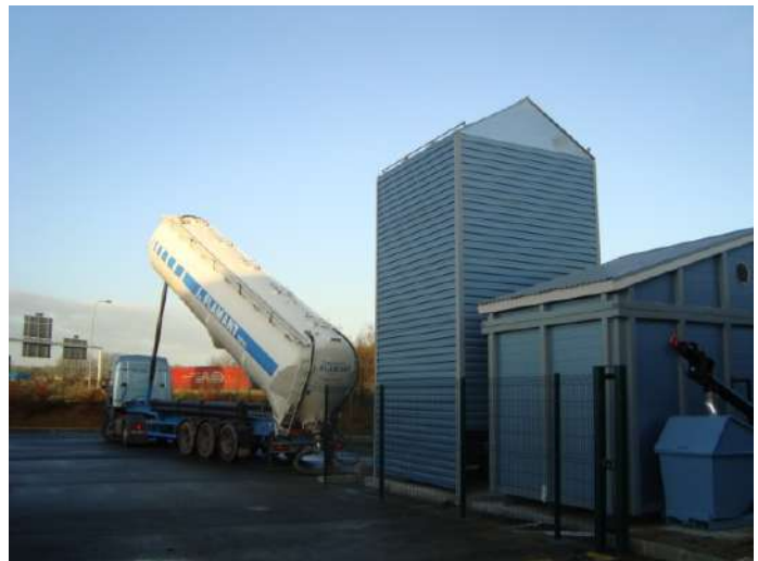
Livraison par camion souffleur 25 tonnes
