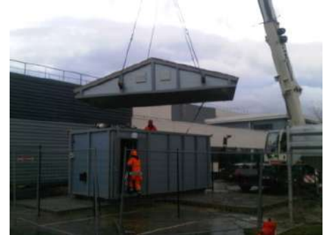
Grutrage du conteneur
