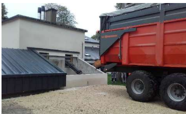
Photo de la fosse de dépôtage
